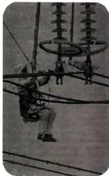
"Τεχνίτης σε εργασία, υπό 400.000 βολτ. Φοράει στολή η οποία ενσωματώνει επιφανειακά ένα πλέγμα από ασημένια συμπαγιστικά"
