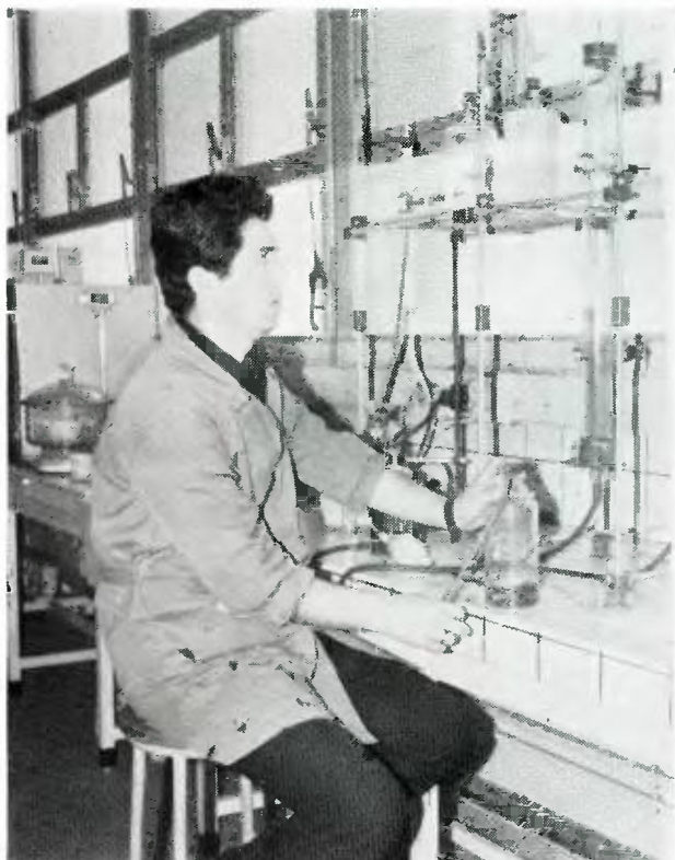
Ἡ συσκευή "Bitterfeld" γιὰ τὸν προσδιορισμὸ ἀνθρακικῶν εἰς τὰ διαλύματα ἐνῶ τὴν χειρίζεται ὁ κ.Κανναβός.
