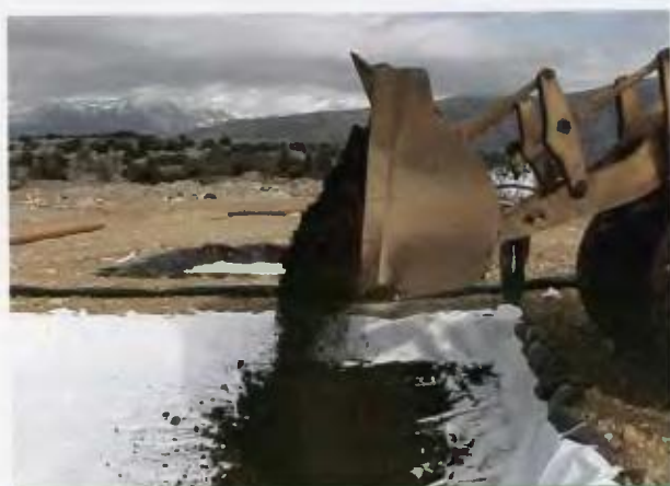
Πλήρωση τμημάτων με κατάλοιπα βωξίτη
