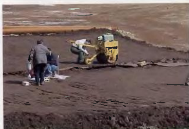
Συμπύκνωση στρώσεων υλικού ΚΒ
