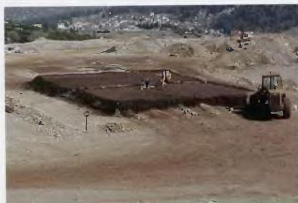
Πιλοτική δοκιμή - τελευταίο στάδιο κατασκευής
