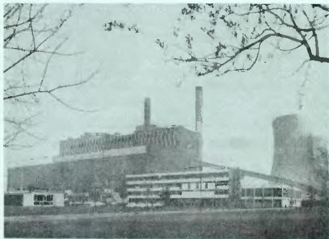
Κλασική μορφή σύγχρονης μονάδος παραγωγής ήλεκτρικής ενέργειας.
