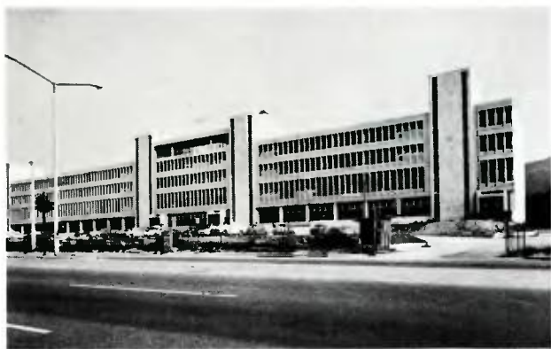
Κτίριο Ε.Ι.Ρ.Τ. Αγίας Παρασκευής. Η «ZALOUMIN» χρησιμοποίησε 100 τόννους προφίλ αλουμινίου.
