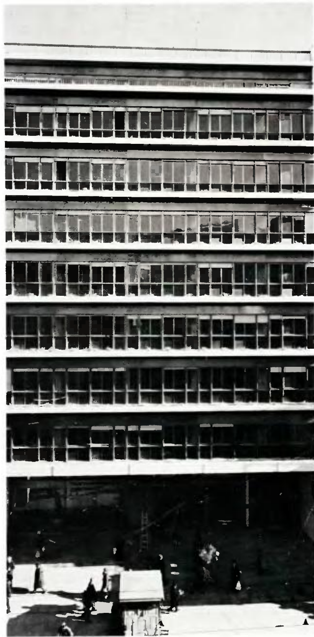
Κτίριο γραφείων στα Χαυτεία (Αθήναι). Μία ακόμη εργασία τής «ΖΑΛΟΥΜΙΝ».
