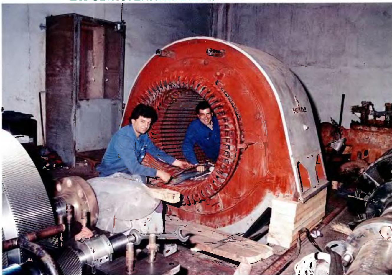
Οι συνάδελφοι, Π. Γιαννακόπουλος και Ι. Μηρουσιανός φανερά ικανοποιημένοι από την πορεία της εργασίας αλλαγής σφηνών, στο στάτι της γεννήτριας. Όπως φαίνεται και στη φωτογραφία, ο στάτις χρειάστηκε να υπερυψωθεί για να βγει ο ρότορας, ο οποίος μόλις διακρίνεται δεξιά.
