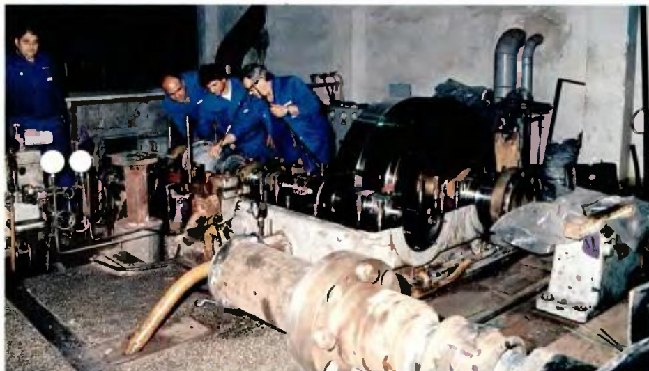
Οι συνάδελφοι Λ. Ζάκας, Η. Παπαδημητρόπουλος, Π. Γιαννακόπουλος και ο κ. Muller ενώ μετρούν τα διακена στο ρότορα του στροβίλου. Στα δεξιά διακρίνεται ο ανοικτός μειωτήρας με το εντυπωσιακό γραναζι εξόδου (ταχύτητα περιστροφής του τελευταίου 1500 στρ./λεπτό, ενώ του στροβίλου 10.000 στρ./λεπτό).
