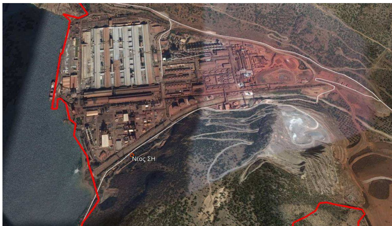
Σχήμα 1.3.3-1: Απόσπασμα google Earth όπου σημειώνεται κεντροβαρικά η θέση του νέου σταθμού παραγωγής ηλεκτρικής ενέργειας ονομαστικής ισχύος 826 MW
