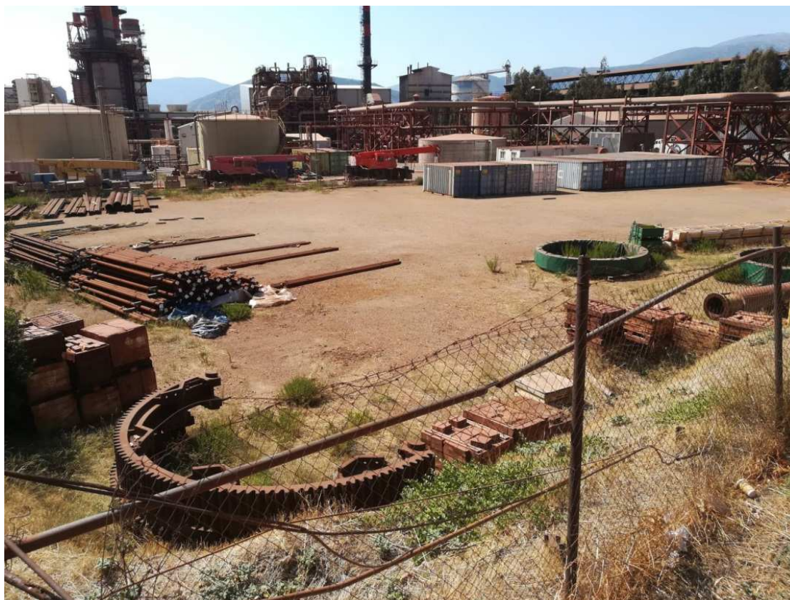
Φωτ. 4: Άποψη της ενδεικτικά προτεινόμενης θέσης εγκατάστασης της εργοταξιακής μονάδας παραγωγής σκυροδέματος.
