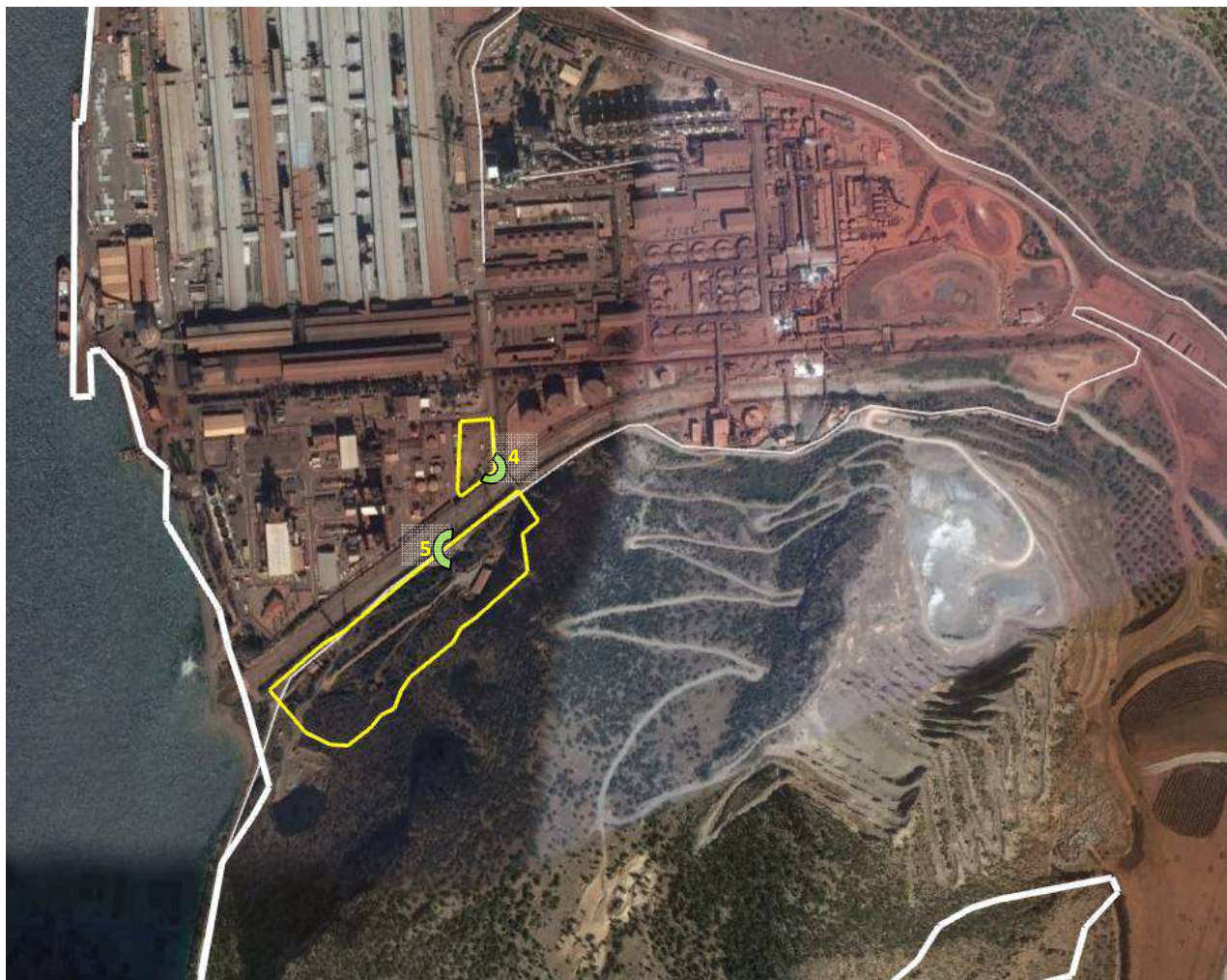
Φωτ. 3: Απεικόνιση θέσεων λήψης φωτογραφικής τεκμηρίωσης της ενδεικτικά προτεινόμενης θέσης εγκατάστασης των εργοταξιακών εγκαταστάσεων κατασκευής του νέου σταθμού παραγωγής ηλεκτρικής ενέργειας
