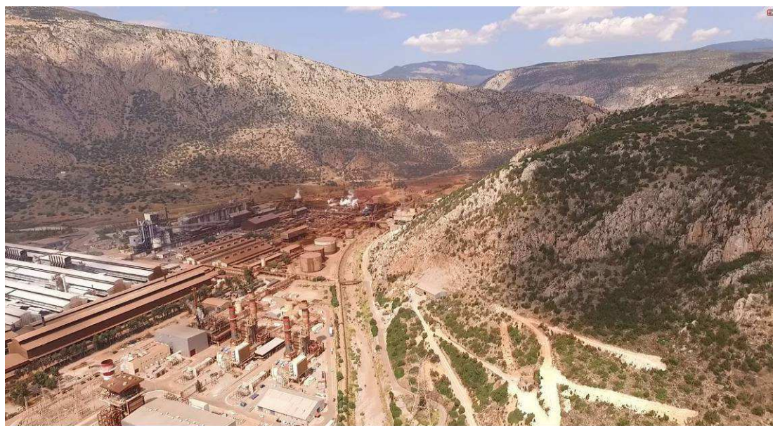
Φωτ. 2: Πανοραμική άποψη της ευρύτερης περιοχής ανάπτυξης του νέου σταθμού παραγωγής ηλεκτρικής ενέργειας και των εργοταξιακών εγκαταστάσεων
