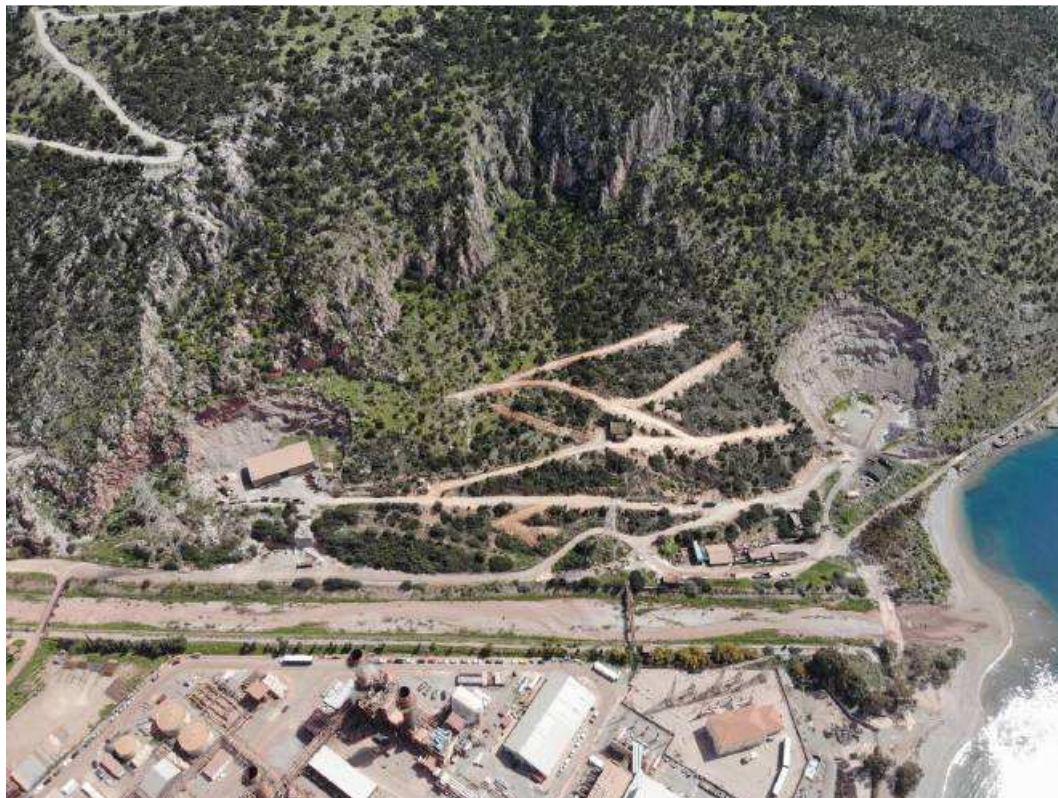
Φωτ. 1: Πανοραμική άποψη της ευρύτερης περιοχής ανάπτυξης του νέου σταθμού παραγωγής ηλεκτρικής ενέργειας και των εργοταξιακών εγκαταστάσεων
