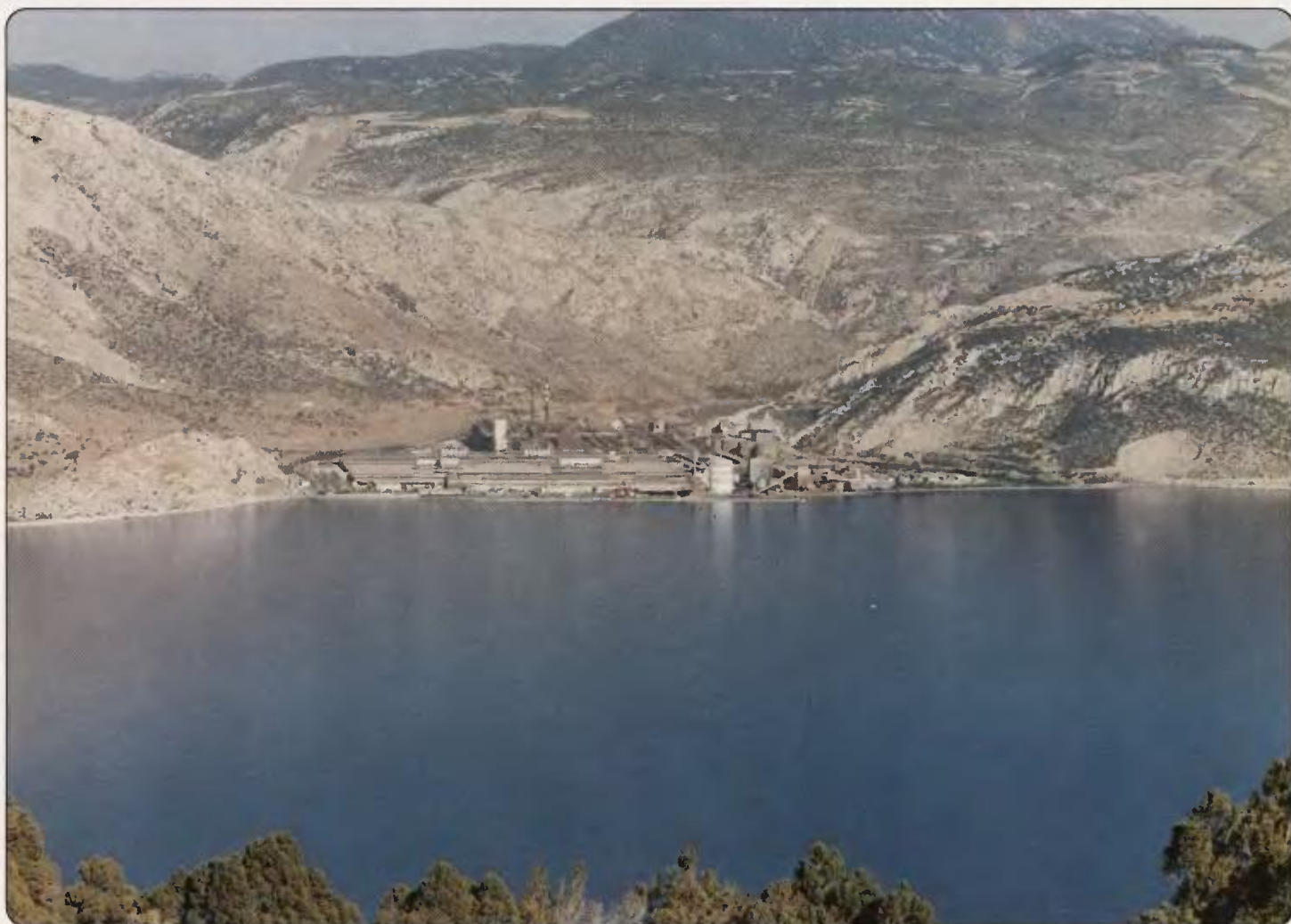
Γενική άποψη των εγκαταστάσεων της "Αλουμίνιον της Ελλάδος" από Δυτικά.
