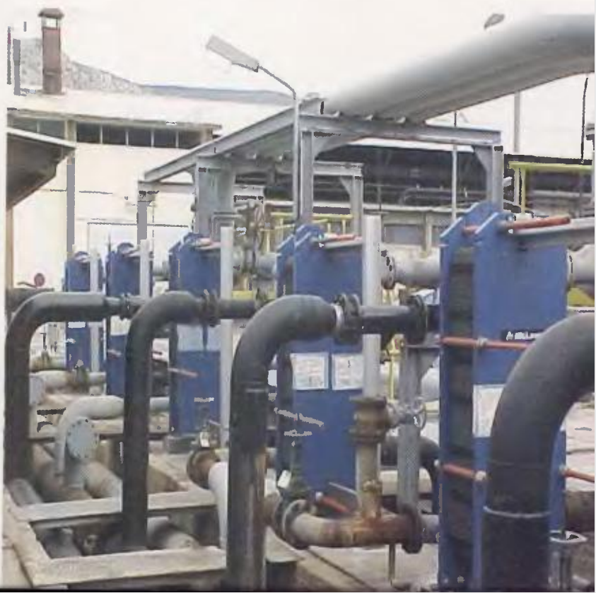
1) ΕΝΑΛΛΑΚΤΕΣ ΧΥΤΗΡΙΟΥ 2) ΕΓΚΑΤΑΣΤΑΣΗ ΕΚΦΟΡΤΩΣΗΣ ΚΩΚ
