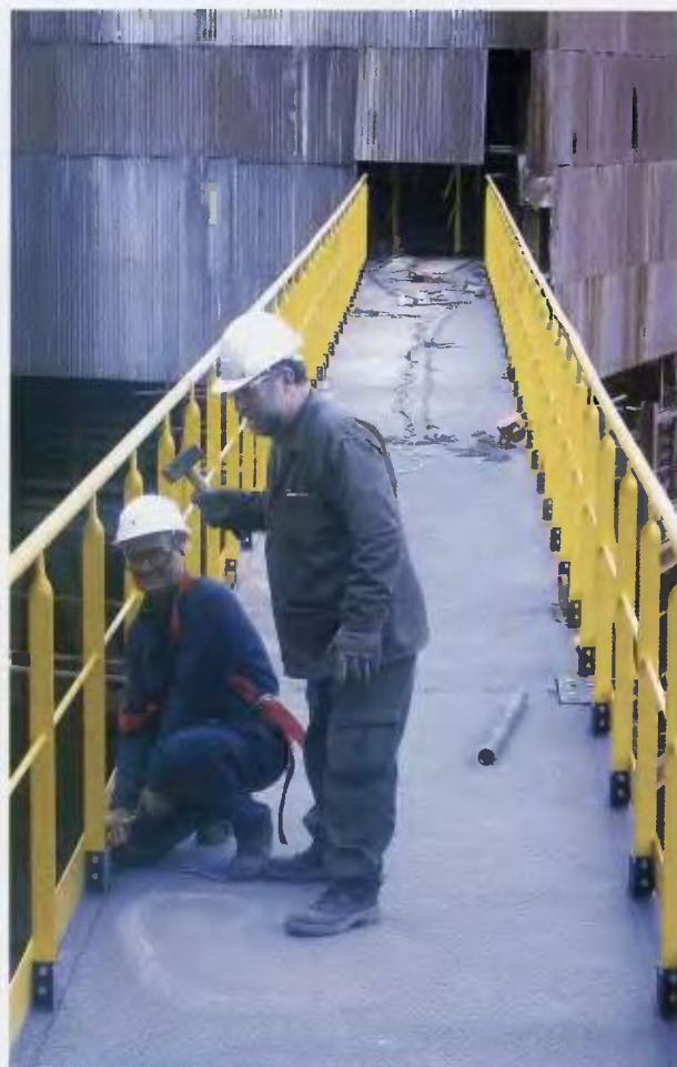
Η πασαρέλα μεταξύ τμήματος φίλτρων παραγωγής και Λευκής Διήθησης θα παραδοθεί σε λίγες ημέρες από την κατασκευάστρια Εταιρεία 3ΚΠ.
