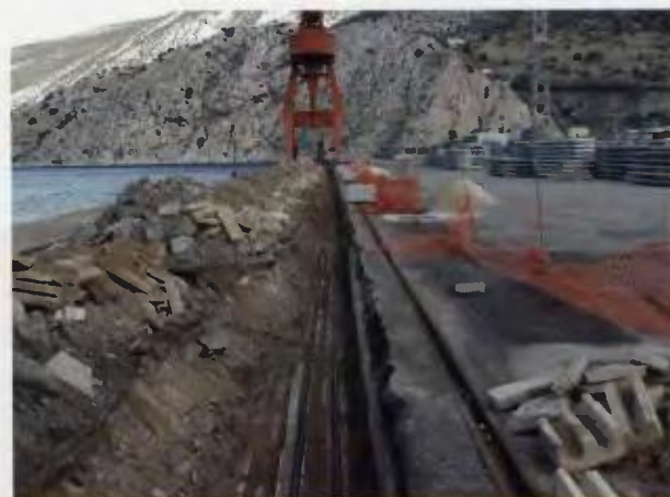
Κατά την αντικατάσταση των καλωδίων...
