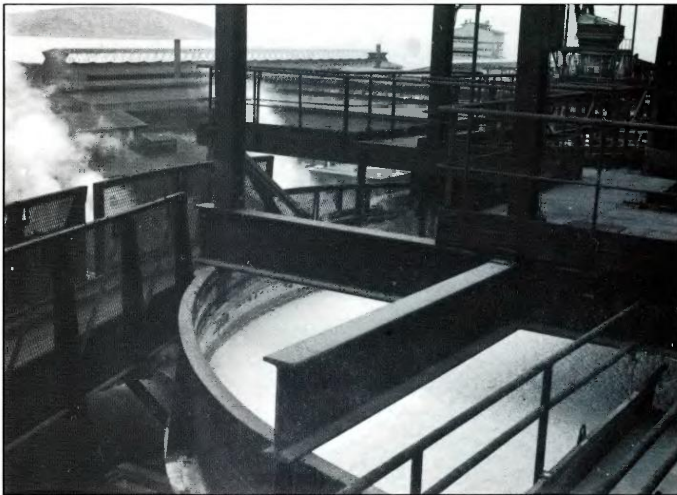
Δεξαμενή Διασπάσεως αλουμίνας
