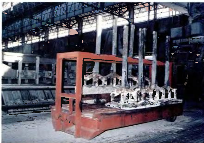
Πλατφόρμα μεταφοράς ανόδων με παλαιές και νέες ανόδους σταθμευμένη στον κεντρικό διάδρομο της σειράς (νέος τρόπος).
