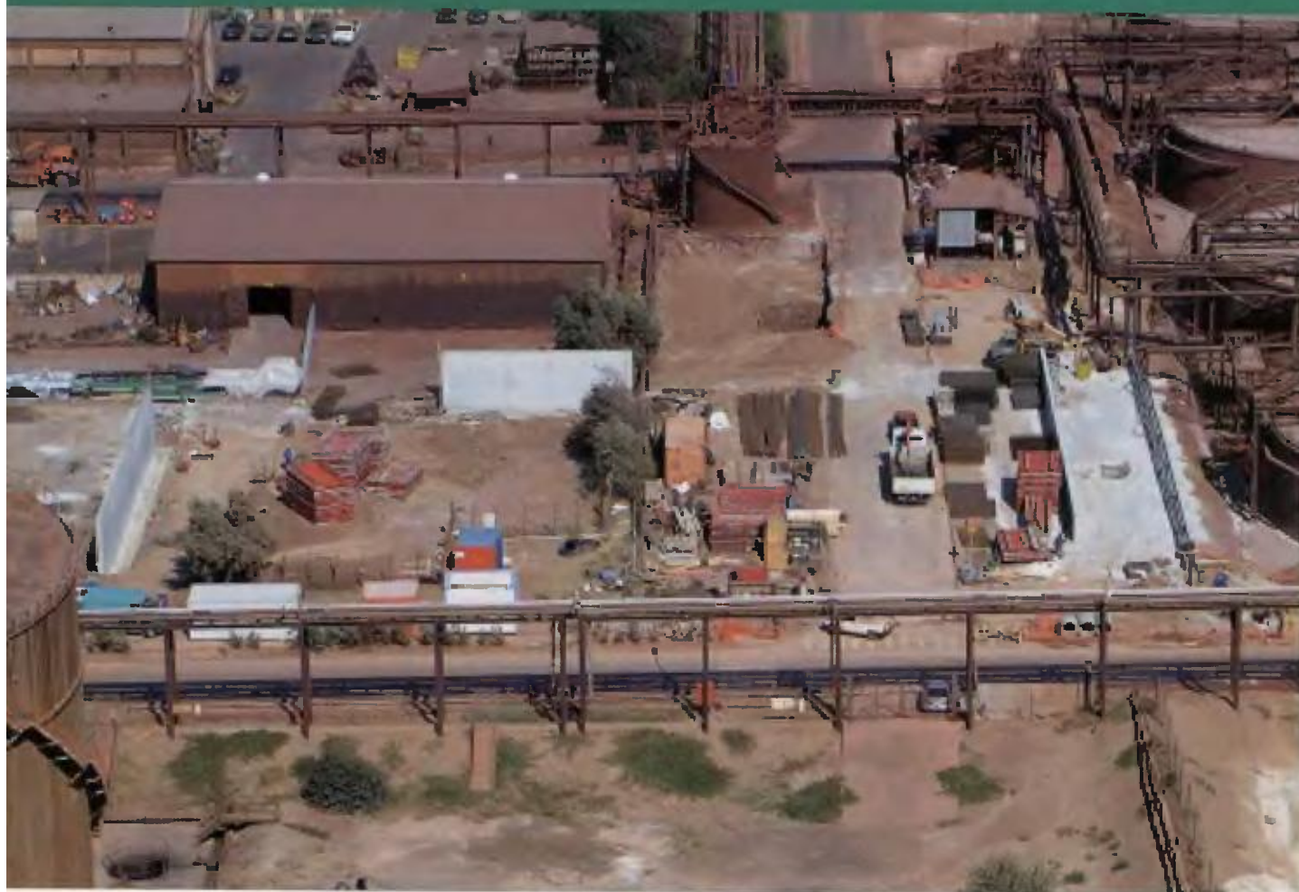
Το εργοτάξιο του έργου είναι σε εξέλιξη, στη διασταύρωση των δρόμων L1 και T4, ανάμεσα στους laneurs 14 και 15, τις δεξαμενές πετρελαίου και την κεντρική αποθήκη.
