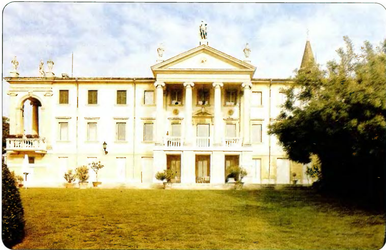
Τα προϊόντα αλουμινίου βρίσκουν εφαρμογή όχι μόνο στα νέα κτίρια, αλλά επίσης στην ανακατασκευή, αναπαλαίωση και εκσυγχρονισμό των παλαιών. Σε μερικές χώρες η ανακατασκευή αποτελεί την μεγαλύτερη αγορά.
