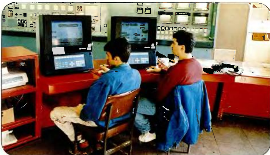
Οι συνάδελφοι Α. Ζήβαδας και Ν. Σαλιπάς, χειρίζονται τα PC στην ανανεωμένη αίθουσα ελέγχου του τμήματος Καθίζησης-Πλύσης στην Αλουμίνη.
