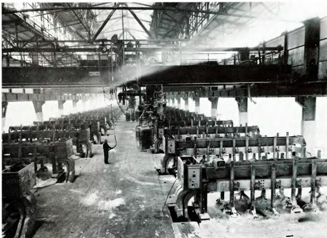
Λεκάνες ηλεκτρολύσεως πριν τοποθετηθούν σκέπαστρα.
