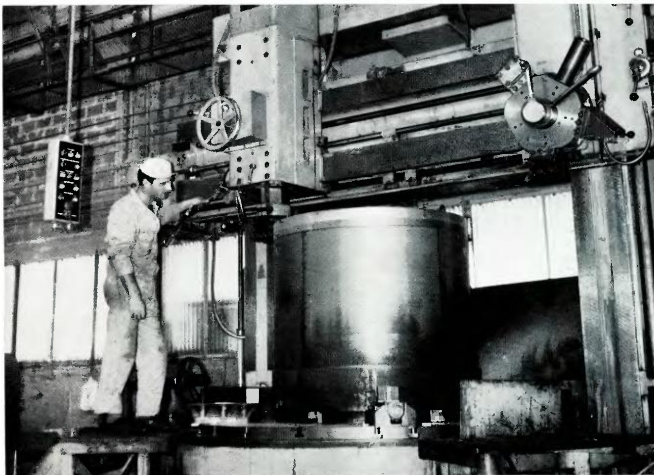
Κατεργασία στον κάθετο τόρνο ενός εξαρτήματος της πρέσας ανόδων από τον κ. Σπ. Μήλιο.
