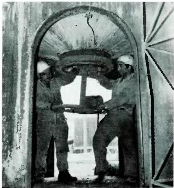
Οἱ κ.κ. Α. Πουρνάρας και Α. Βασιλόπουλος ἐνῶ ἀποσυν-αρμολογοῦν τὸν καυστήρα πυρώσεως τῶν αὐλῶν ἐνὸς αὐτοκλείστου κλιβάνου τοῦ τμήματος προσβολῆς.
