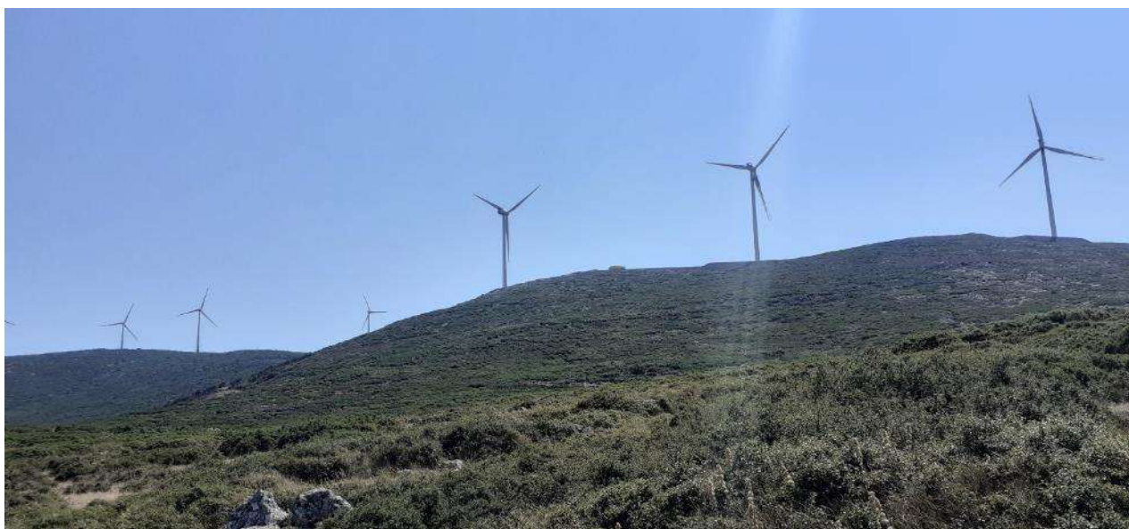
Φωτ. 4: Γενική άποψη εγκατάσταση του πυλώνα Π10Ν.
