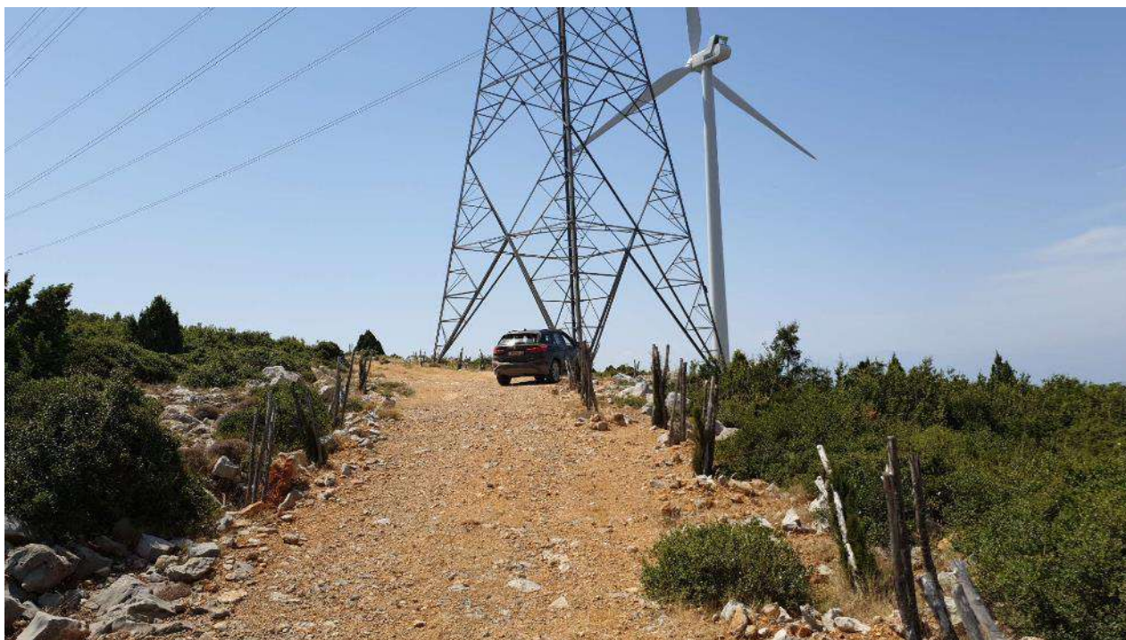
Φωτ. 8: Άποψη του προς αποξήλωση πυλώνα Π12 από τη θέση εγκατάστασης του πυλώνα Π12ΕΝ.
