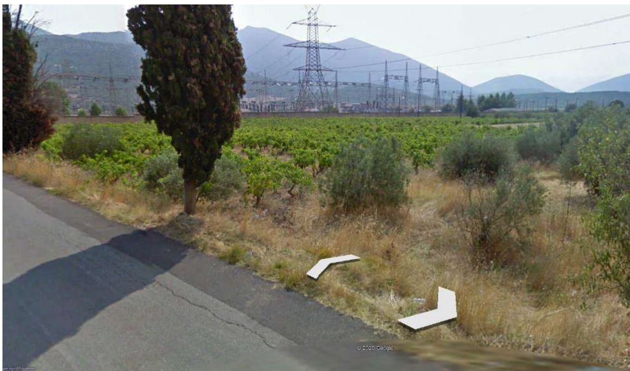
Φωτ. 2: Γενική άποψη της θέσης εγκατάστασης του πυλώνα Π2Ν.
