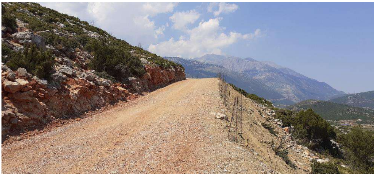
Φωτ. 5: Γενική άποψη εγκατάσταση του πυλώνα Π11Ν.
