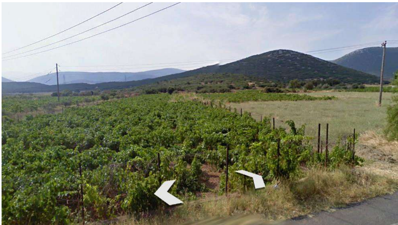
Φωτ. 3: Γενική άποψη της θέσης εγκατάστασης του πυλώνα Π3Ν.
