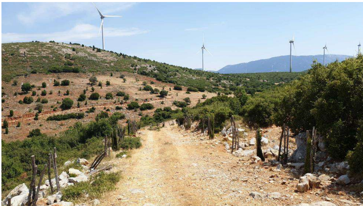
Φωτ. 7: Γενική άποψη εγκατάσταση του πυλώνα Π12ΕΝ.
