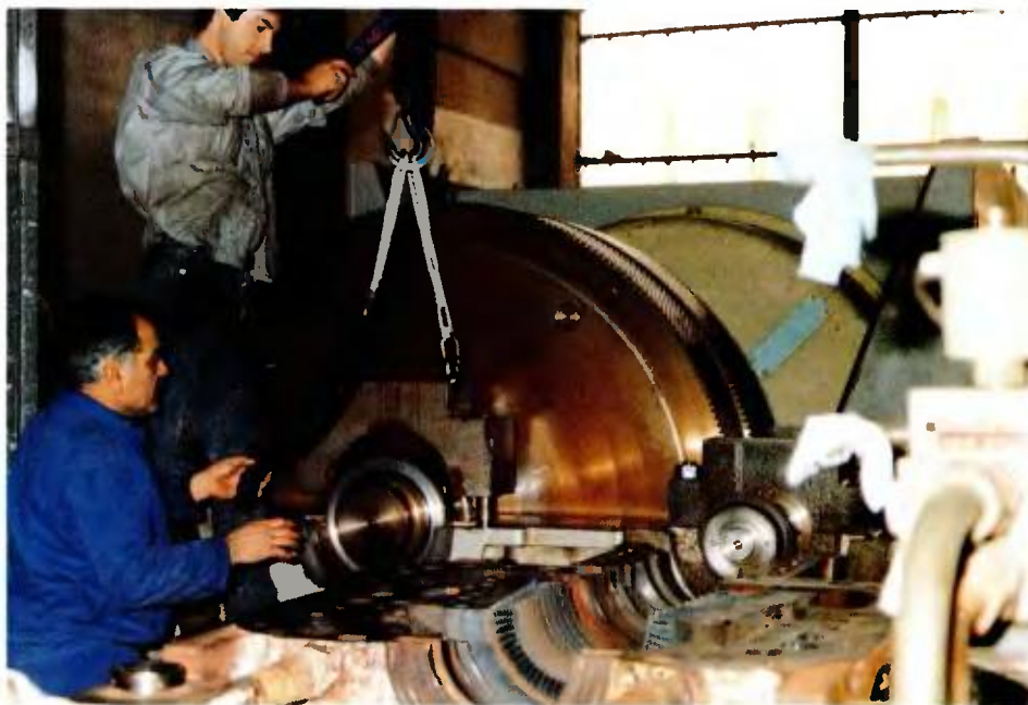
Επέμβαση στον μειωτήρα της στροβιλογεννήτριας από συνεργείο συντήρησης (ΜΙ/ΟΧ).
