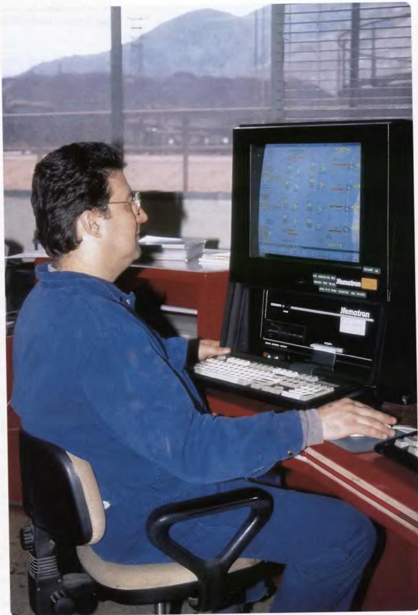
Κεντρικός ηλεκτρονικός έλεγχος λειτουργίας του Τμήματος Παραγωγής Ενέργειας, δυναμικότητας 320 τόνων/ώρα υπέρθερμου ατμού.
