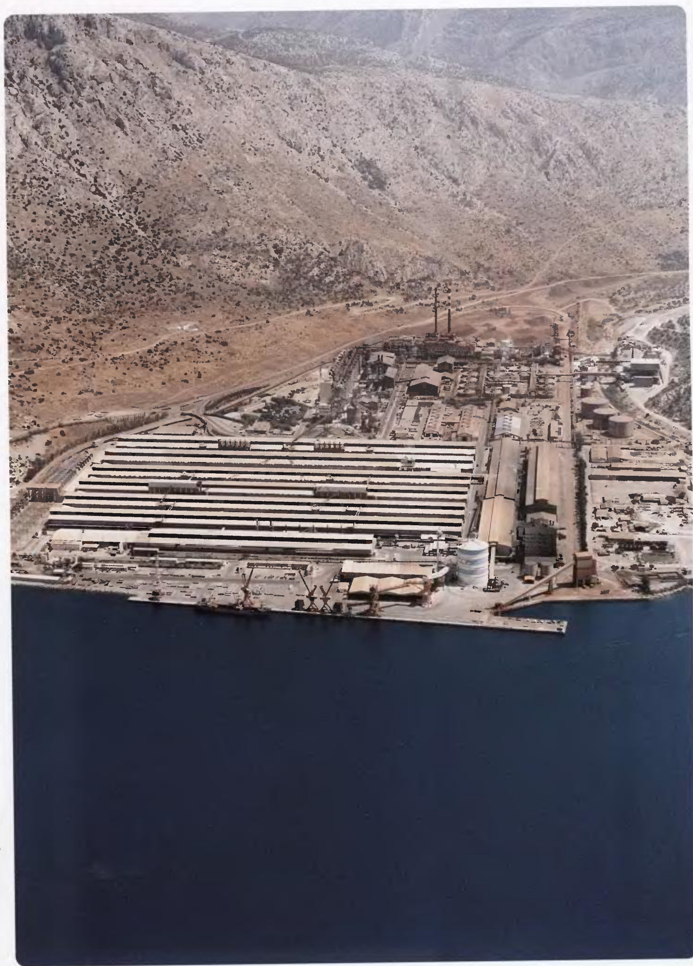
Γενική άποψη του Εργοστασίου της Αλουμίνιον της Ελλάδος στον Άγιο Νικόλαο Βοιωτίας (Αεροφωτογραφία 1995).
