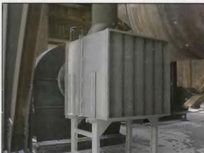
Ένας ταραξίας σε περιορισμό. Ηχοπαγίδα σε ανεμιστήρα του πρωτεύοντα αέρα των φούρνων αλουμίνας. Μείωση θορύβου κατά 18dB.
