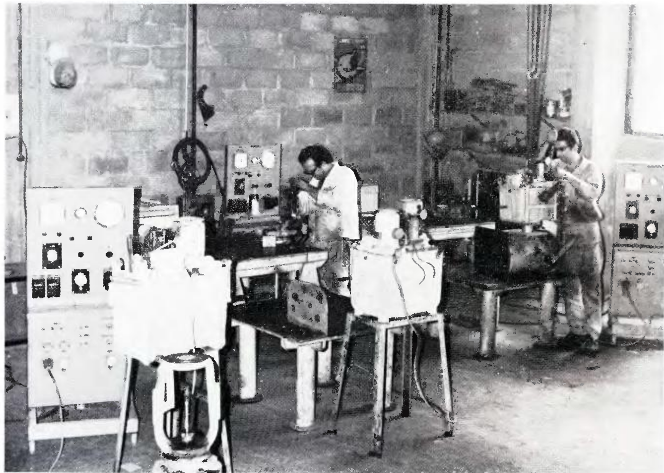
Οἱ κκ. Ἐξηντάρης καὶ Παραδείσης πραγματοποιοῦν τὴν συντήρησι τῶν ἡλεκτρο-ὑδραυλικῶν σερβοκινητήρων.
