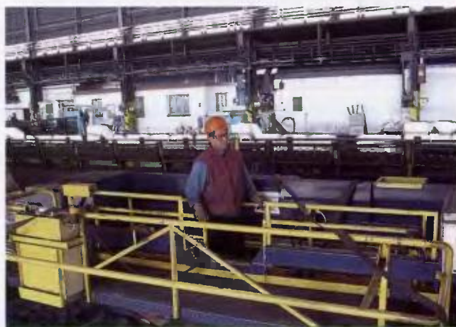
Κινητή πλατφόρμα. ...ο κίνδυνος πτώσης του εργαζόμενου έχει εξαλειφθεί πλήρως
