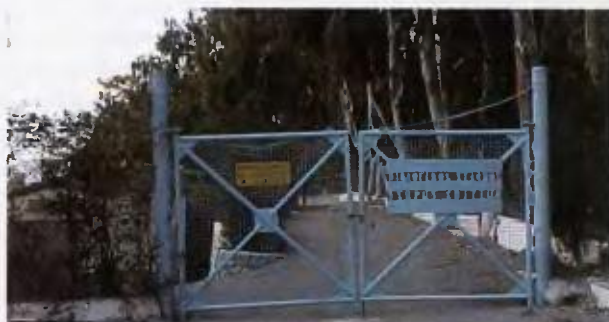
Είσοδος Βιολογικού Σταθμού Άσπρων Σπιτιών & Αντίκυρας
