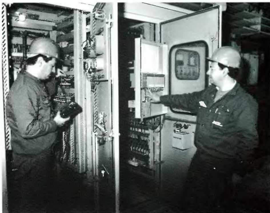
Ο κ. Ι. Ζούλης (αριστερά) και ο κ. Ν. Κοκκινάρης εμπρός σ' ένα ηλεκτρολογικό ερμάριο ενός γκρουπ ανόρθωσης, που μόλις έχει εφοδιασθεί με το PLC της Allen Bradley. Στις κάτω φωτογραφίες εικονίζεται το PLC σε λειτουργία και μια από τις απεικονίσεις μέρους του γκρουπ 1 στην οθόνη
