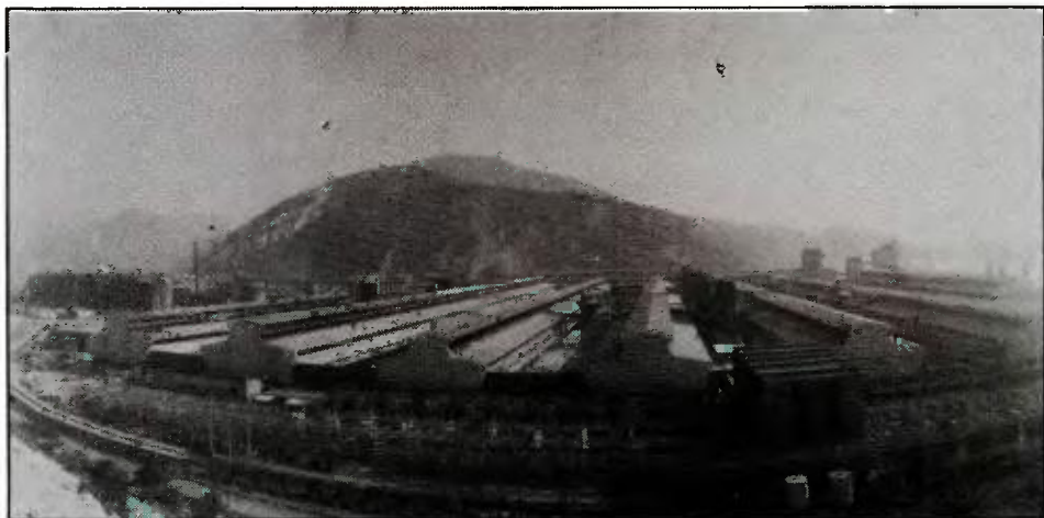
Ο Υποσταθμός του Εργοστασίου
